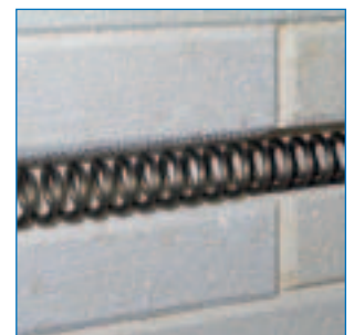
Verwarmingselementen in groeven geplaatst (KE-L en KE-N).
